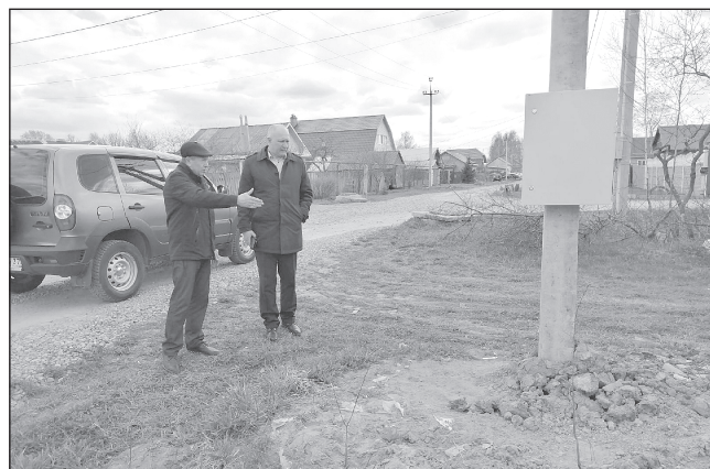
В. Г. Нагацкий: установка современных энергосберегающих светодиодных светильников, замена воздушных линий на провода с изоляцией поможет сократить количество аварийных ситуаций в городе
